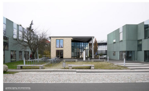
Energetische Sanierung und Umgestaltung | Geomatikum HS-Anhalt Dessau
